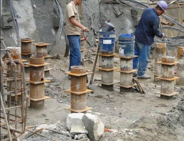
Figura 27 Construcción de cortina de micropilotes.
