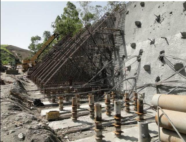
Figura 28. Cortina de micropilotes y armado de pantalla y contrafuertes.
