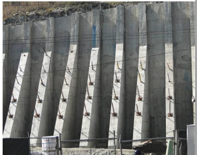
Figura 31. Detalle de estructura anclada construida.
