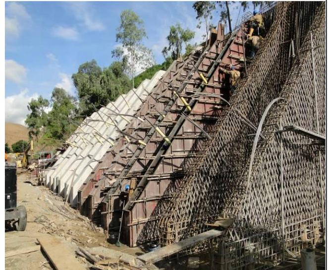
Figura 30. De izquierda a derecha: Contrafuertes vaciados, encofrados y en proceso de armado.
