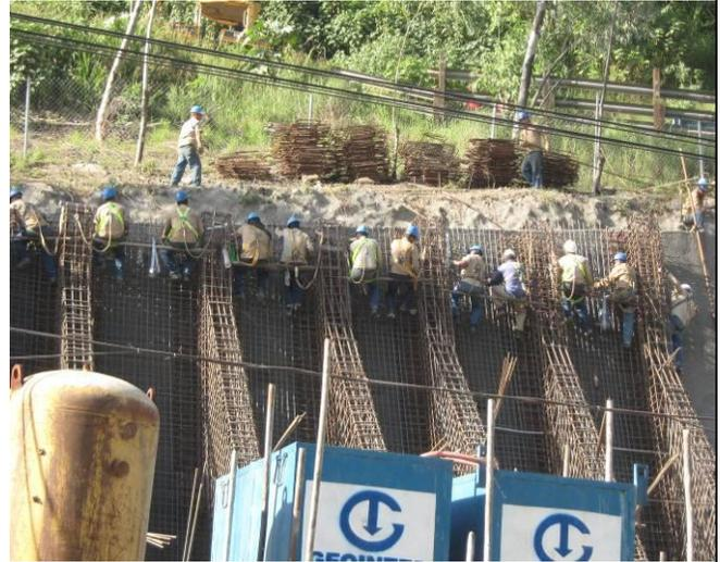
Figura 29. Armado de pantalla y contrafuertes.
