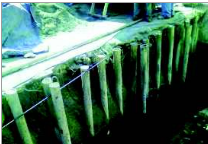
FIG. 16. Detalle de las cortinas de micropilotes, primaria y secundaria.
