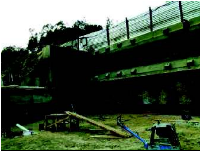
FIG. 37. Vista de las dos primeras filas de anclajes en la cortina principal, y vista de las cortinas laterales.
