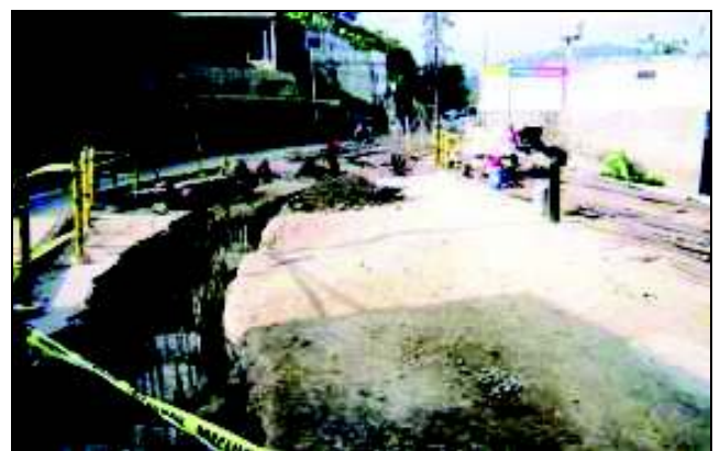
FIG. 25. Detalle de ejecución de la cortina de pilotes.
