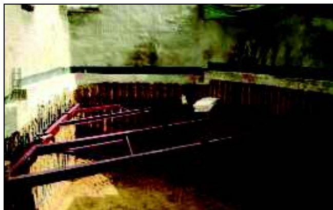
FIG. 15. Ejemplo de cortina de micropilotes apuntalada temporalmente con cerchas metálicas (Zuloaga, 2006).
