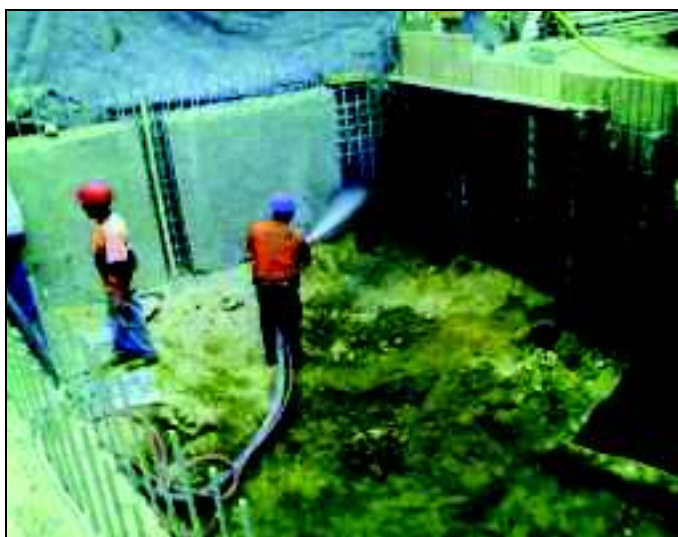
FIG. 18. Construcción de muros perimetrales permanentes.
