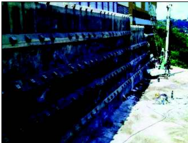
FIG. 39. Cortina principal anclada e inicio de construcción de los pilotes de fundación de la edificación.
