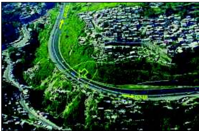
FIG: 52. Vista aérea del sector afectado por el deslizamiento.
