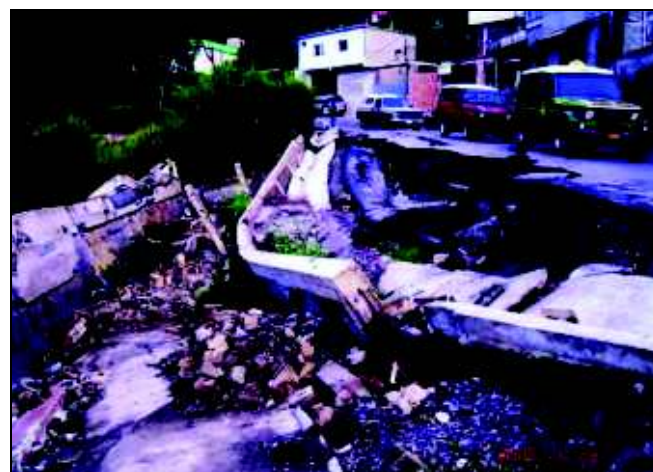
FIG. 21. Detalle de la zona crestal del deslizamiento.
