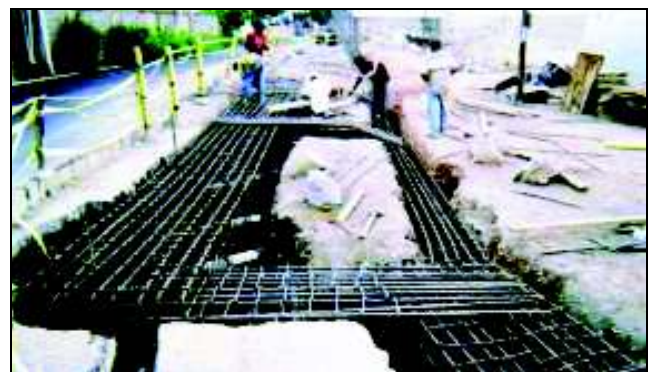
FIG. 26. Viga cabezal, vigas en voladizo y viga de borde.
