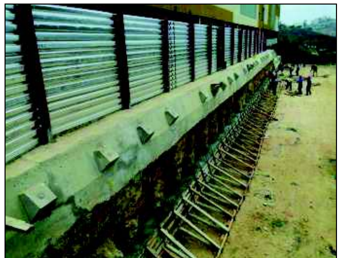
FIG. 36. Primera fila de anclajes e inicio de la construcción de la viga de repartición de la segunda fila.
