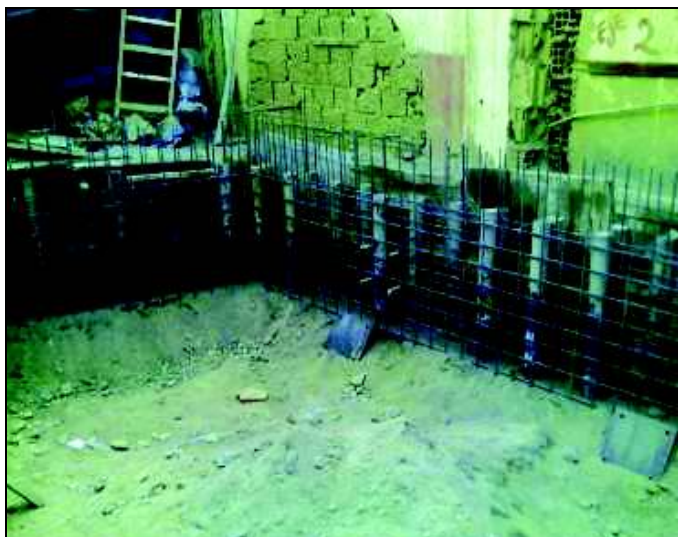
FIG. 17. Inicio de construcción de muros perimetrales permanentes, incorporados a la cortina de micropilotes secundaria.
