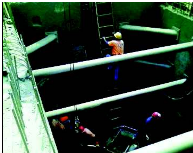
FIG. 19. Detalle de apuntalamiento de los muros perimetrales.
