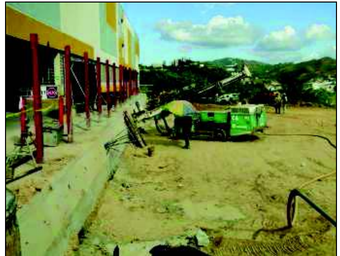
FIG. 35. Construcción de la primera fila de anclajes de la cortina principal.
