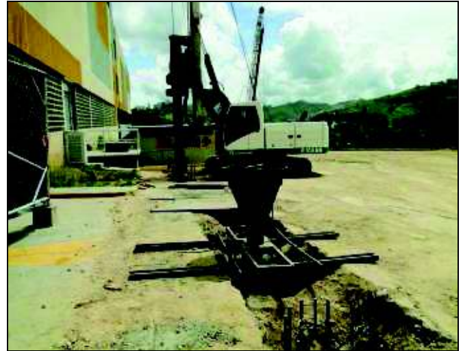
FIG. 34. Inicio de construcción de las cortinas de pilotes.
