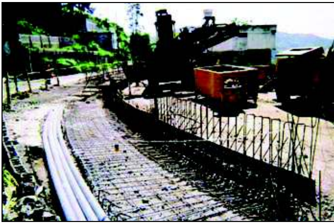
FIG. 27. Ejecución de anclajes a través de las reservaciones en la viga cabezal.
