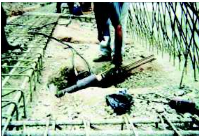
FIG. 28. Puesta en tensión de anclajes.
