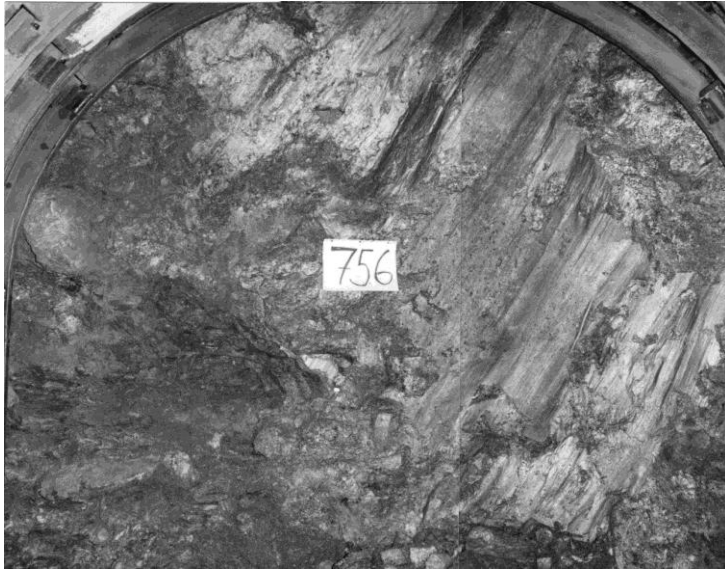
Figuras 7a y 7b. Superficies pulidas y estriadas (slickensides), dentro la brecha de falla encontrada en las galerías exploratorias a 75.6 m del portal de entrada. Las galerías fueron excavadas con un ancho de 2.9 m.
