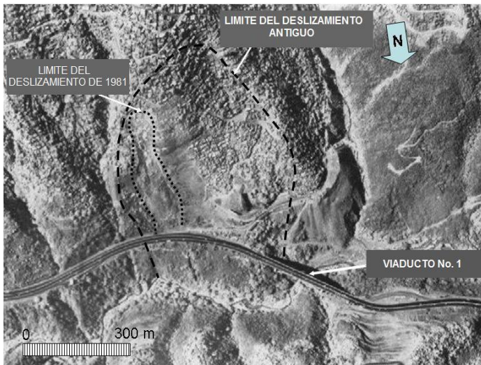
Figura 4. Límite del deslizamiento ocurrido en el año 1981, dentro de los límites del deslizamiento antiguo.
