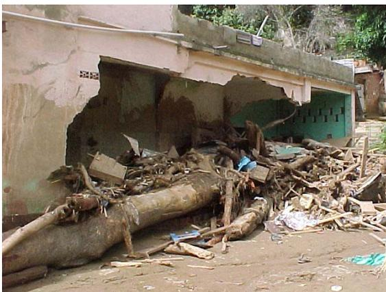
Fig. 14. Daño causado por un tronco de árbol en una vivienda de la quebrada Catuche, Caracas.
