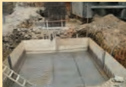
Colocación de armadura para zapata de fundación
