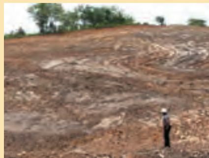
Figura 18 Fotos antes y después del deslizamiento de una zona de rocas intensamente plegadas y cizalladas.
