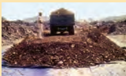
Figura 40 Ejemplos de utilización de geosintéticos para construcción de terraplén en un suelo blando
