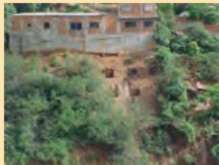
Figura 68 Excavaciones para fundaciones de una vivienda en ladera
