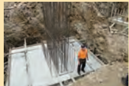
Concreto vaciado en zapata de fundación
