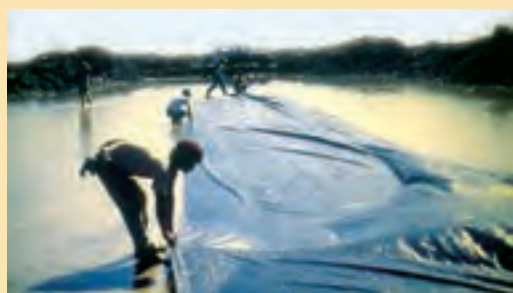
Figura 40 Ejemplos de utilización de geosintéticos para construcción de terraplén en un suelo blando
