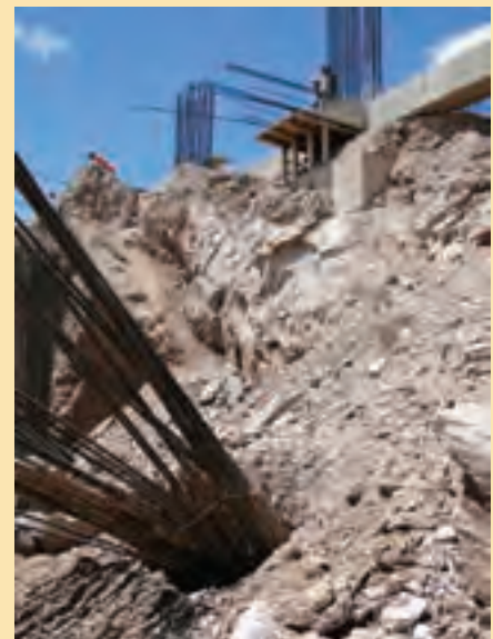
Figura 69 Zapata de fundación construida en cresta de talud
