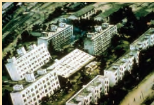
Figura 10 Ejemplo de colapso de edificios por licuación del suelo durante el Terremoto de Nigata, Japón, 1964
