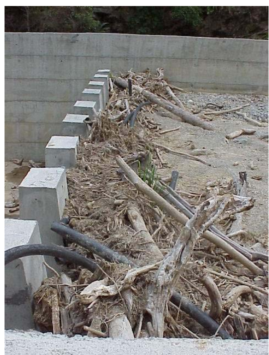
Fig. 24 Presa abierta de concreto en la Cuenca Guanape (Punta de Mulatos). Fotos comparativas tomadas en Diciembre de 2000 al final de construcción, y luego de lluvias fuertes en Diciembre 2001.
