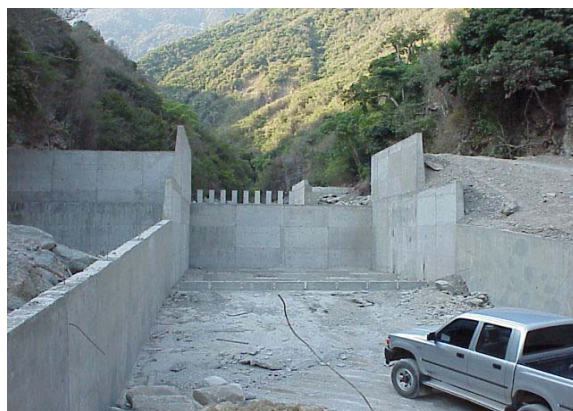
Fig. 23. Presa abierta con área cerrada para acumulación de sedimentos y canal de concreto, en Cuenca Guanape.
