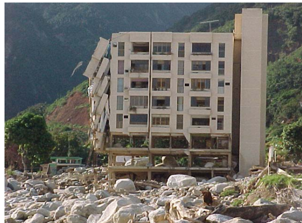
Figura 18. Vista de edificios dañados estructuralmente por el impacto de bloques de roca. (Cono de San Julián). El flujo torrencial pasó a través del tercer piso del edificio mostrado en la última foto.
