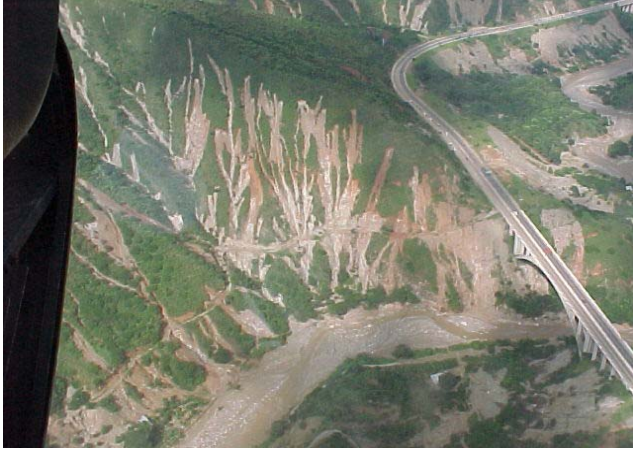
Fig. 6. Foto tomada después del evento de Diciembre 1999, mostrando los típicos deslizamientos en forma de flujos traslacionales. Ladera adyacente a Autopista Caracas-La Guaira.
