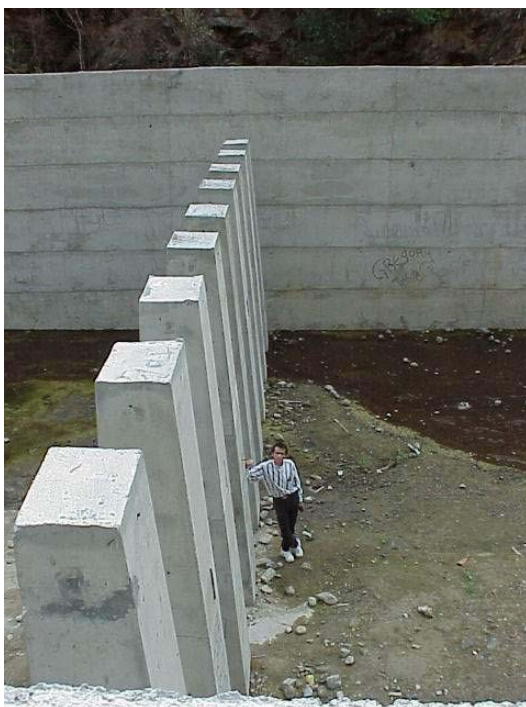
Fig. 24 Presa abierta de concreto en la Cuenca Guanape (Punta de Mulatos). Fotos comparativas tomadas en Diciembre de 2000 al final de construcción, y luego de lluvias fuertes en Diciembre 2001.
