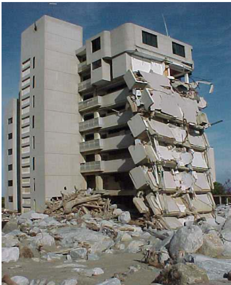
Figura 18. Vista de edificios dañados estructuralmente por el impacto de bloques de roca. (Cono de San Julián). El flujo torrencial pasó a través del tercer piso del edificio mostrado en la última foto.
